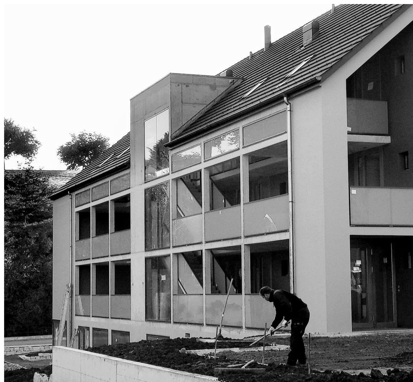
Vergangene Woche waren noch letzte Arbeiten nötig – nun sind die Alterswohnungen aber bezugsbereit.
